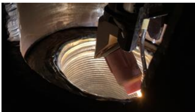
Figura 1: Reparação do bico injetor no local
